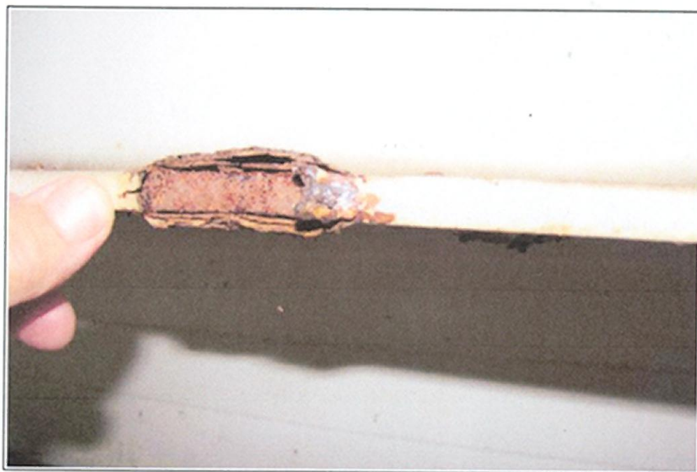
Fot. 1. Hala (od B18) - Korozja belki poziomej
