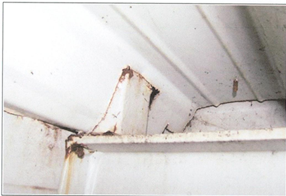
Fot. 26. Hala (od B18) – Korozja w pokryciu dachowym (blacha dachu po cięciu)
