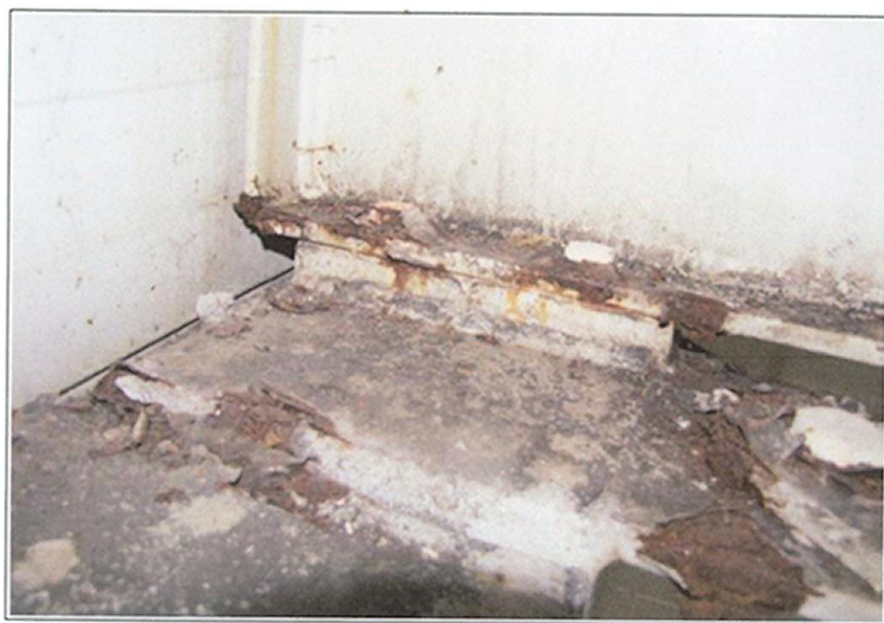
Fot. 22. Hala (od B18) – Korozja w miejscu łączenia ściągów prętowych
