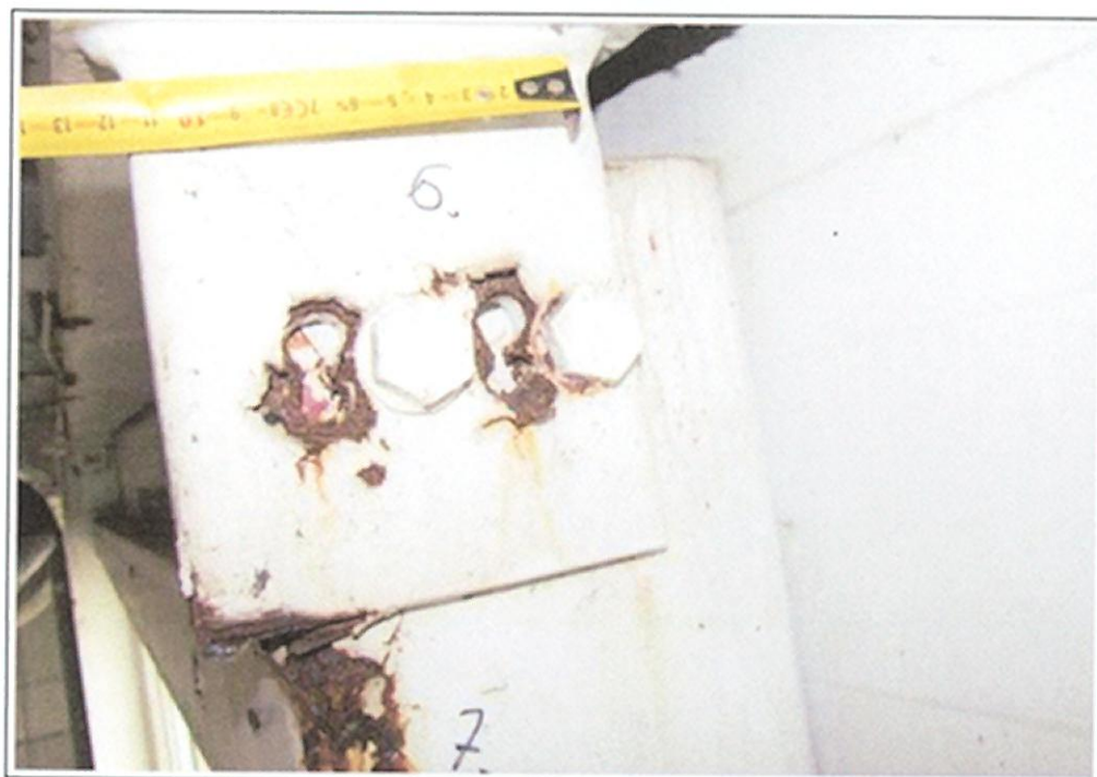
Foto 29. Hala (od B18) – Korozja niedbale wykonanych podczas montażu otworów (do zaspawania podczas rekonserwacji).
