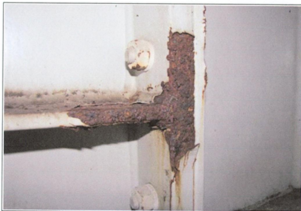
Fot. 2. Hala (od B18) – Korozja belki w miejscu połączenia
