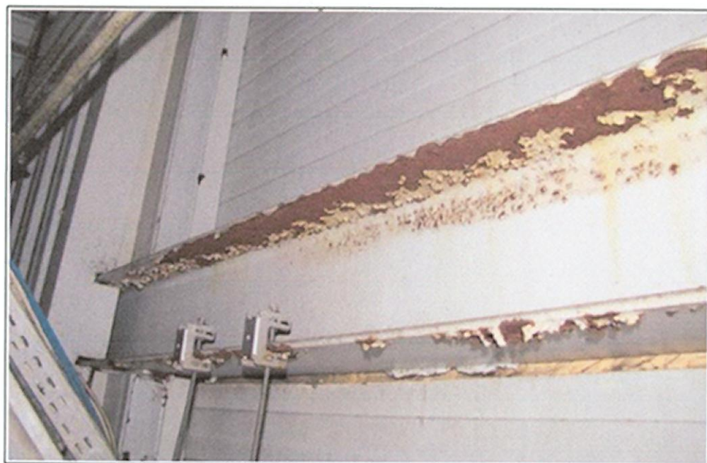
Fot. 40. Hala (od B18) – Korozja belki obok osadnika OS1 /nad drzwiami do kanału wentylacyjnego. Szczegół z fot.39.
