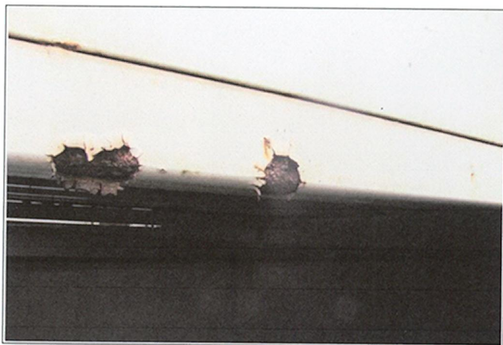
Foto11. Hala (od B18) – Klapa oddymiania/światlik 9 – korozja po uszkodzeniu mechanicznym
