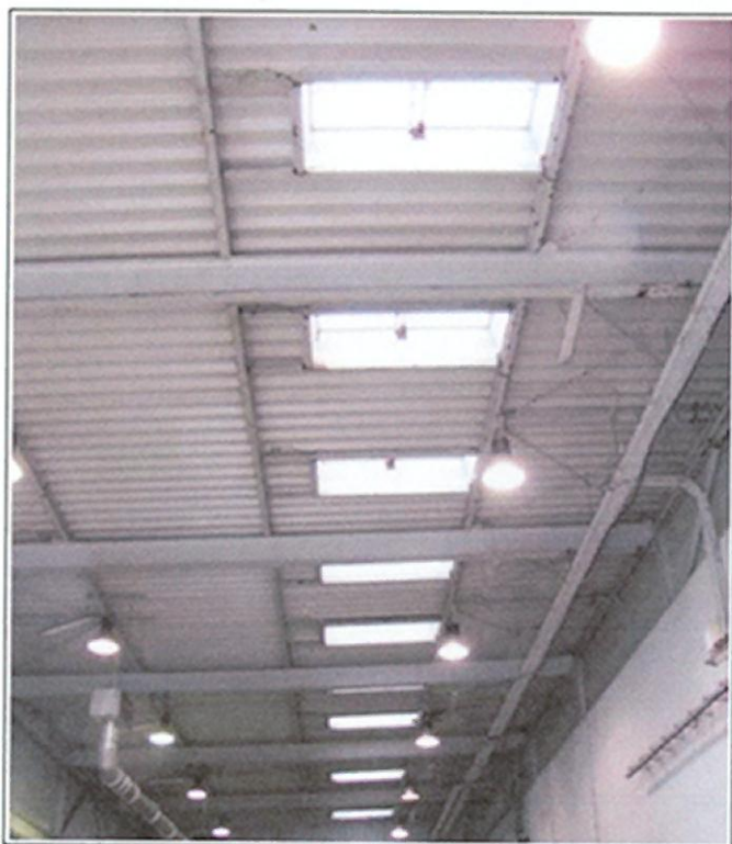
Fot. 52. Hala (od B18) – widok ogólny konstrukcji dachu - kłapy dymowe/światliki
