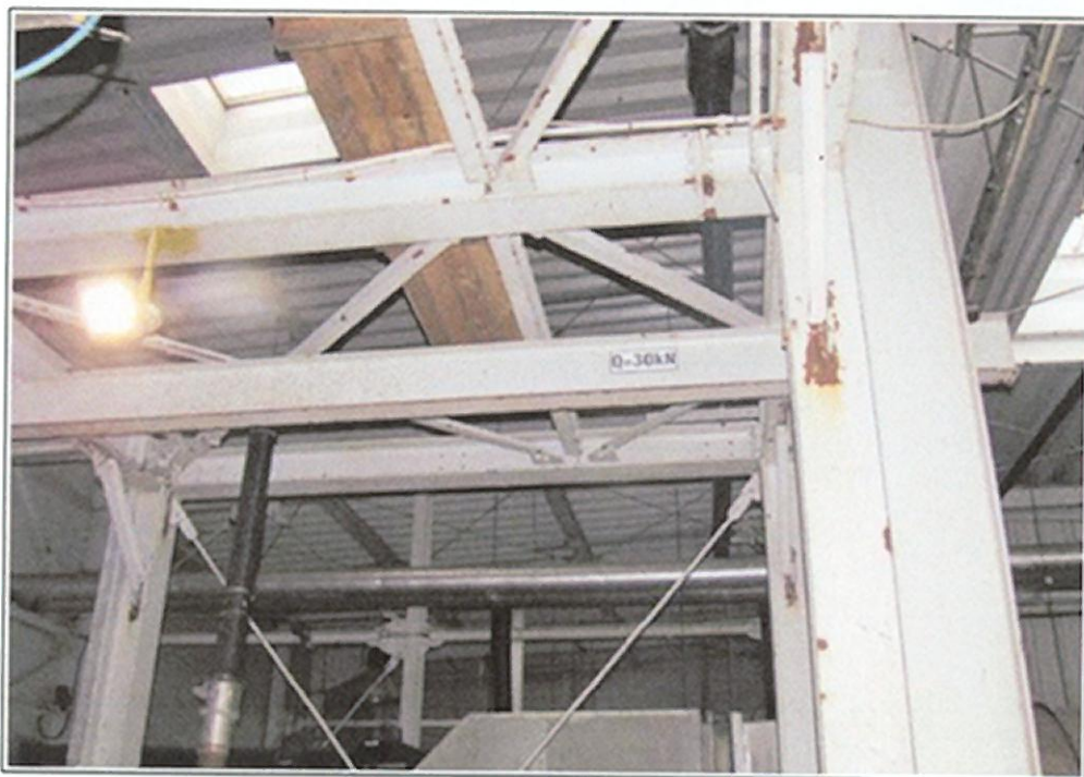
Foto 53. Hala przeróbki pofermentatu 6d2 i konstrukcja wsporcza KW1 – korozja spoin oraz korozja pomontażowa
