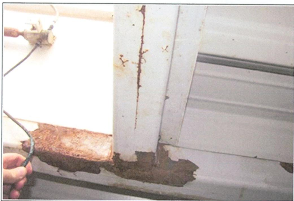
Fot. 14. Hala (od B18) – Kłapa oddymiania/światlik 7 – korozja (bez perforacji)
