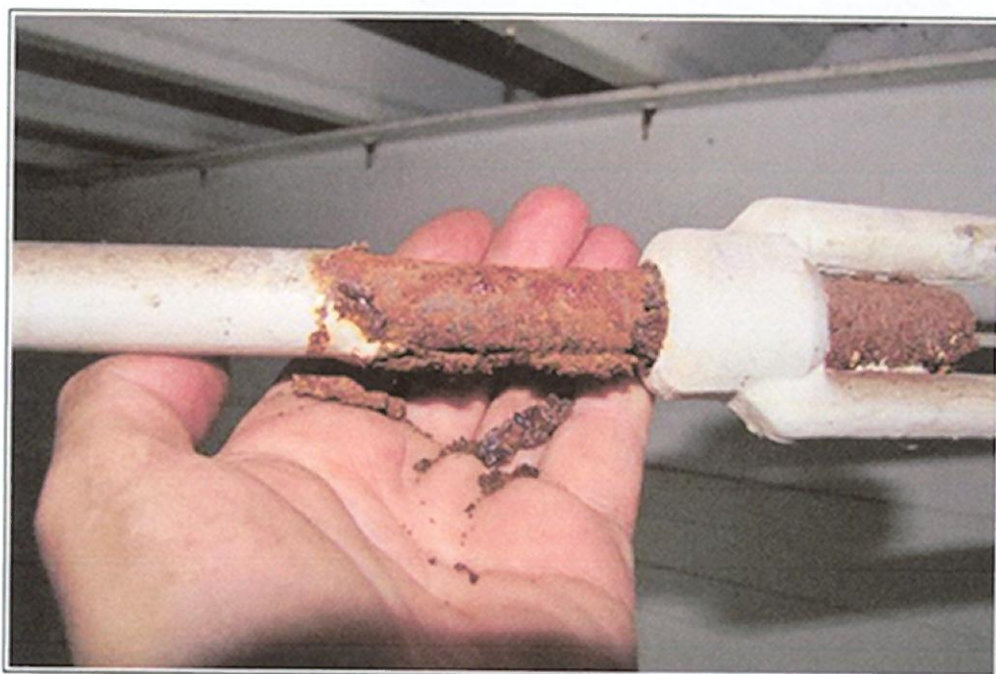
Fot. 24. Hala (od B18) – Korozja gwintu ściagu prętowego – cd
