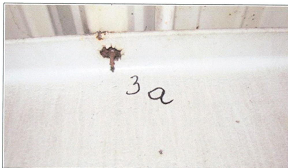
Fot. 28. Hala (od B18) – Typowy przykład korozji połączenia blacha dachowa – belka/płatew (korozja)
