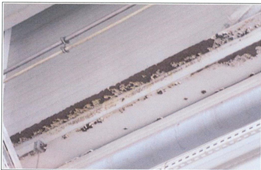
Foto 31. Hala (od B17) – Korozja belki kurtyny powietrznej na wys. 6m, nad bramą B17
