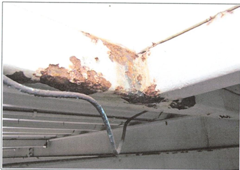
Fot. 8. Hala (od B18) – Kłapa oddymiania/światlik 5 – korozja bez perforacji
