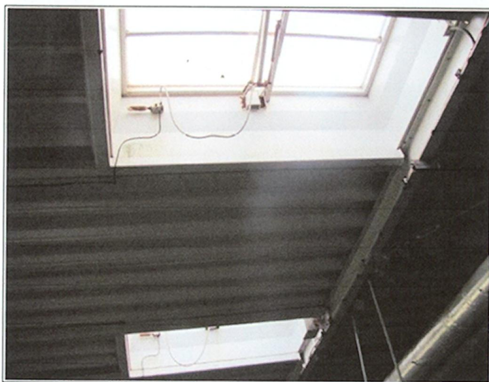
Fot. 36. Hala (od B17) – Kłapa dymowa/światlik 2 i 3 – bez silnej korozji
