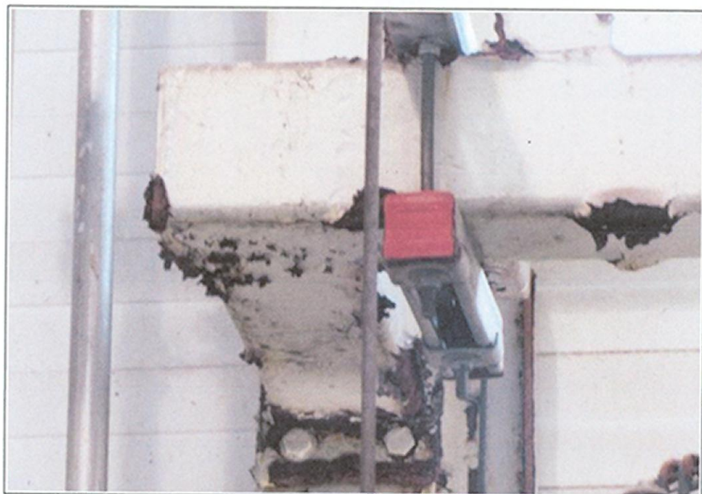
Foto 41. Hala (B18) – Korozja elementów konstrukcji bramy B18
