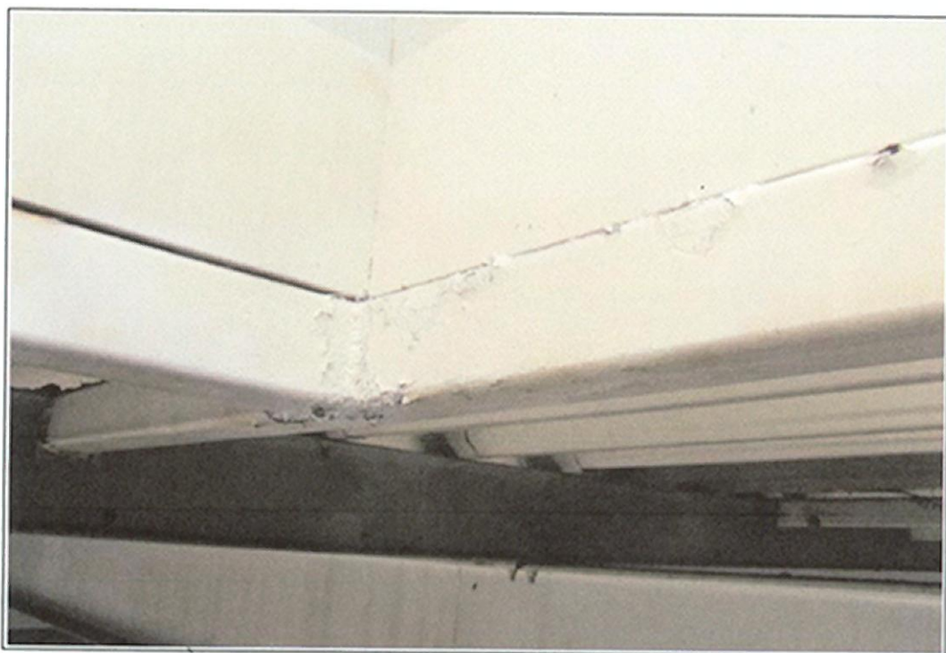
Foto 43. Hala (od B18) – Rama klapy dymowej/światlik 2 – próba malowania
