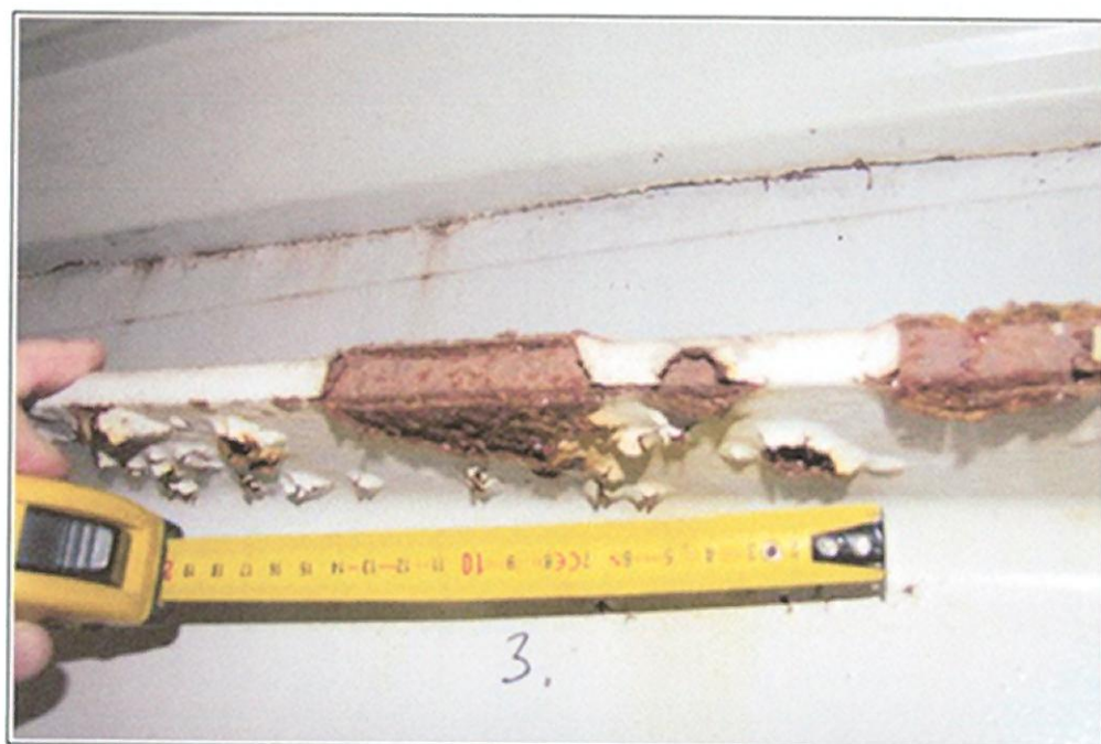
Foto 27. Hala (od B18) – Korozja poziomej belki nośnej
