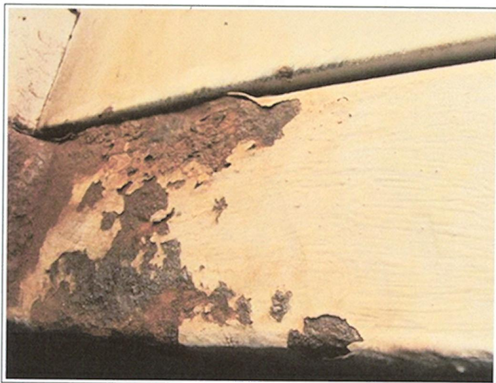
Fot. 48. Hala (od B18) – Klapa dymowa/światlik 7 – produkty korozji
