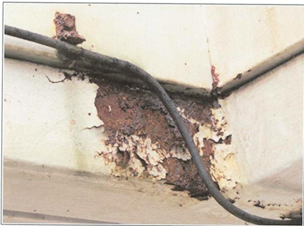
Fot. 44. Hala (od B18) – Klapa dymowa/światlik 1 – korozja (bez perforacji)
