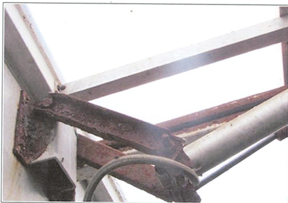
Fot. 12. Hala (od B18) – Klapa oddymiania/światlik 10 – korozja el. trawersów klap oddymiania
