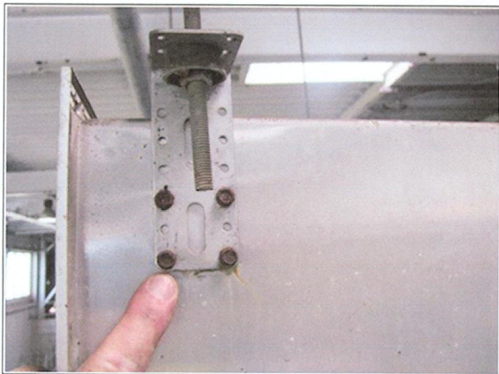
Fot.32. Hala (od B17) – Korozja elektrochemiczna elementów systemu wentylacji (stal nierdzewna - cynk)
