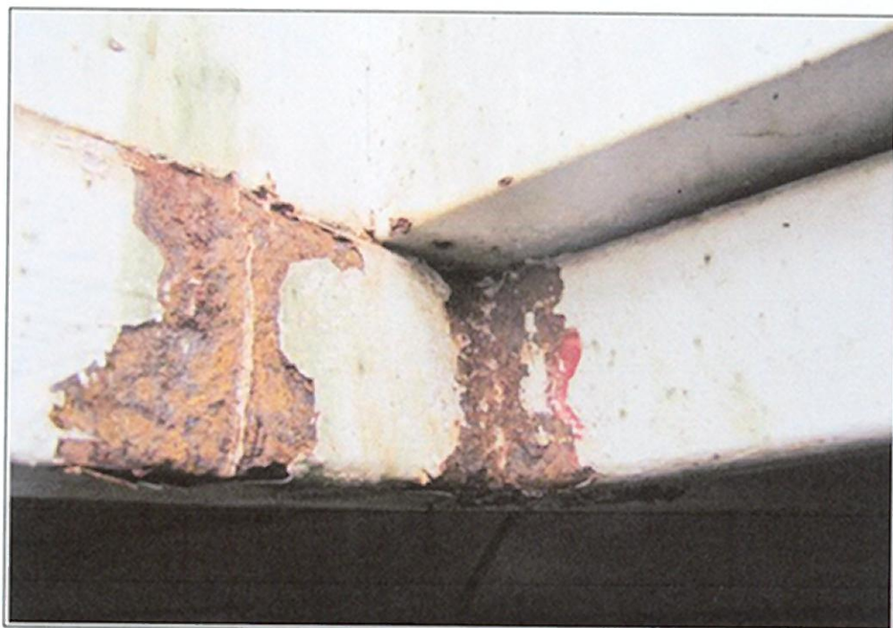
Foto 15. Hala (od B18) – Kłapa oddymiania/światlik 12 – korozja (bez perforacji)
