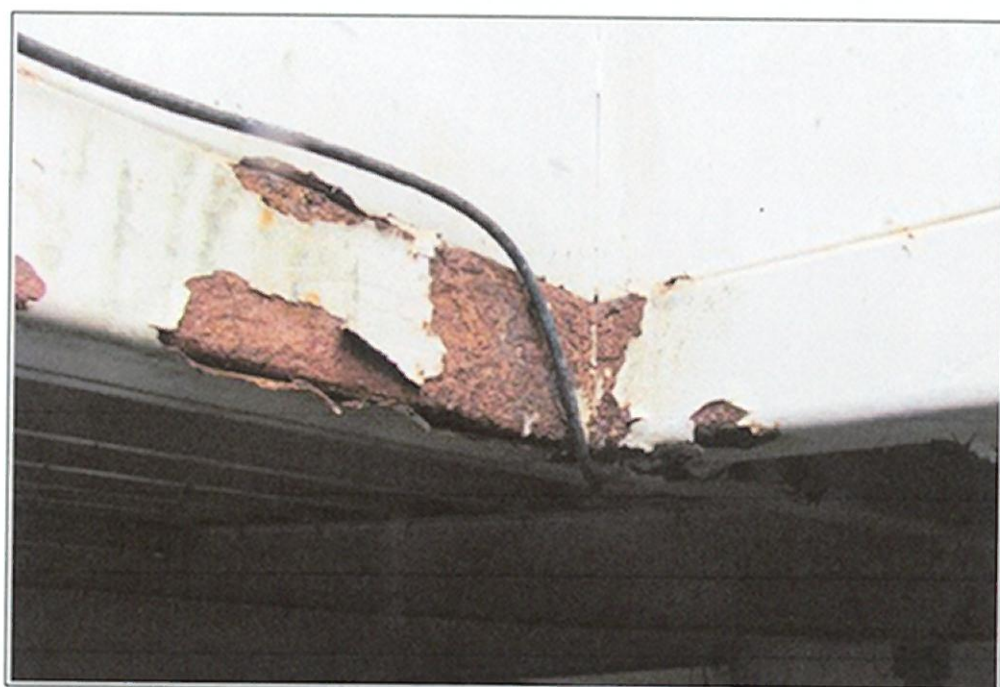
Foto 49. Hala (od B18) – Klapa dymowa/światlik 8 – korozja (bez perforacji)
