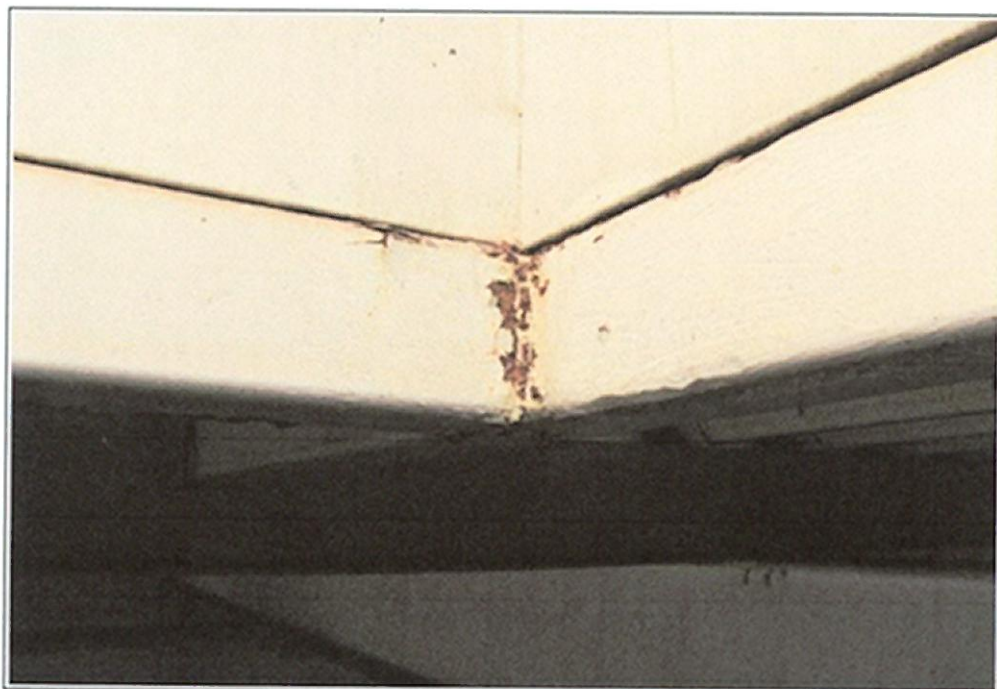
Fot. 10. Hala (od B18) – Kłapa oddymiania/światlik 6 – korozja (bez perforacji)
