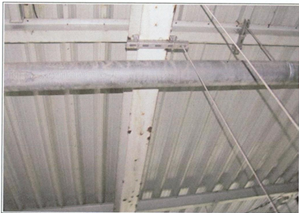
Foto 33. Hala (od B17) – Korozja belki nośnej konstrukcji dachu i elementów podtrzymujących instalację wentylacyjną
