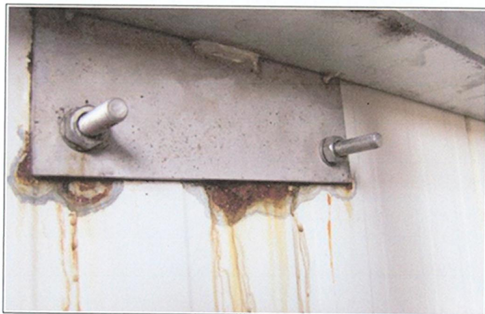
Foto 3. Hala (od B18) – Korozja bramy tunelu
