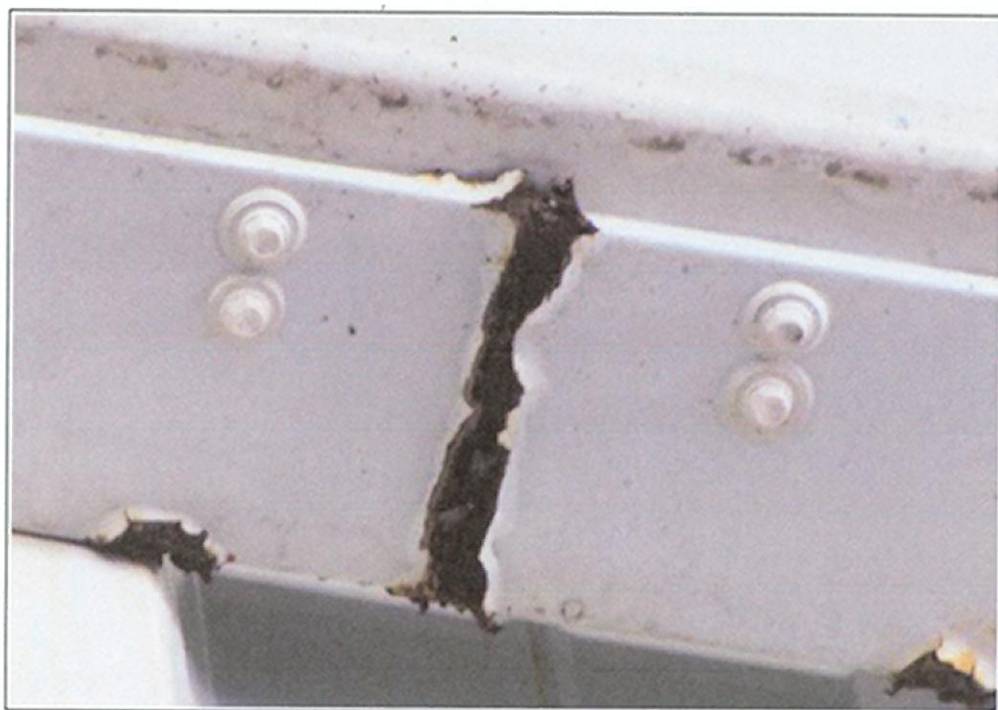
Fot. 34. Hala (od B17) – Belka kurtyny powietrznej nad bramą B17 – korozja połączenia spawanego
