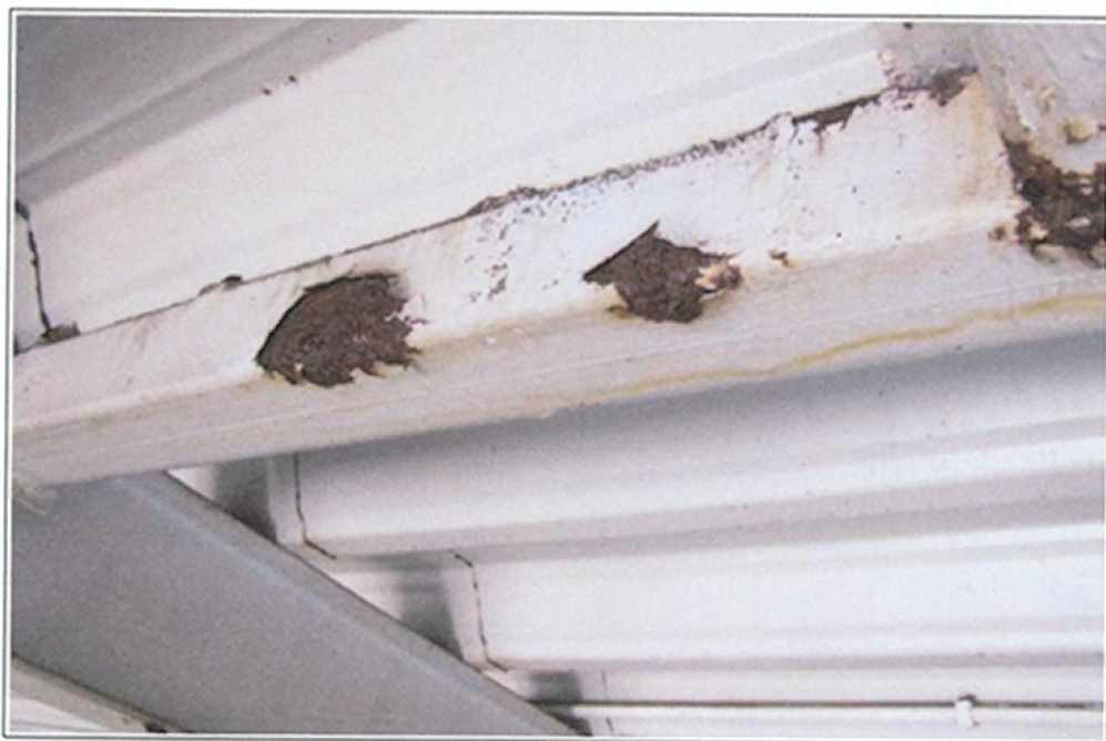
Foto 9. Hala (od B18) – Kłapa oddymiania/światlik 5 – korozja (bez perforacji)
