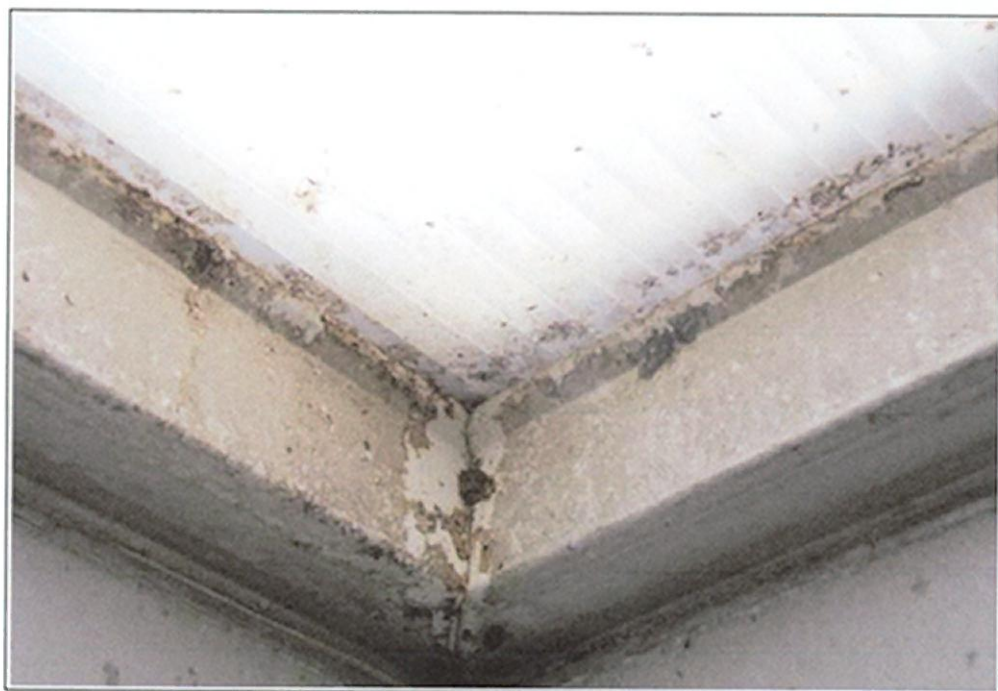
Foto 17. Hala (od B18) – Światlik 10 – przykład korozji organicznej
