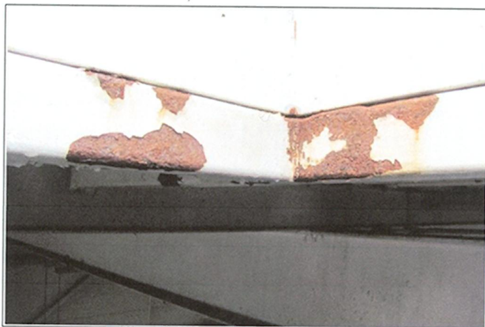
Fot. 50. Hala (od B18) – Klapa dymowa/światlik 8 – korozja (bez perforacji)
