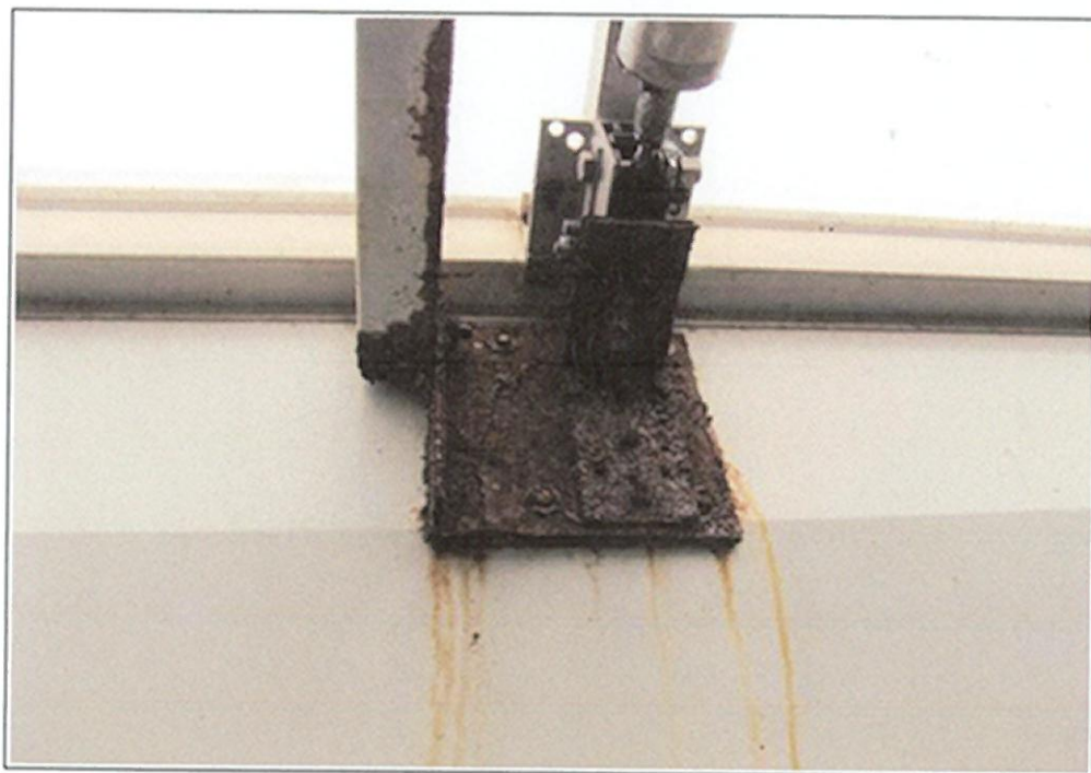
Foto 7. Hala (od B18) – Kłapa oddymiania/światlik 4 – korozja el. trawersów kłap oddymiania
