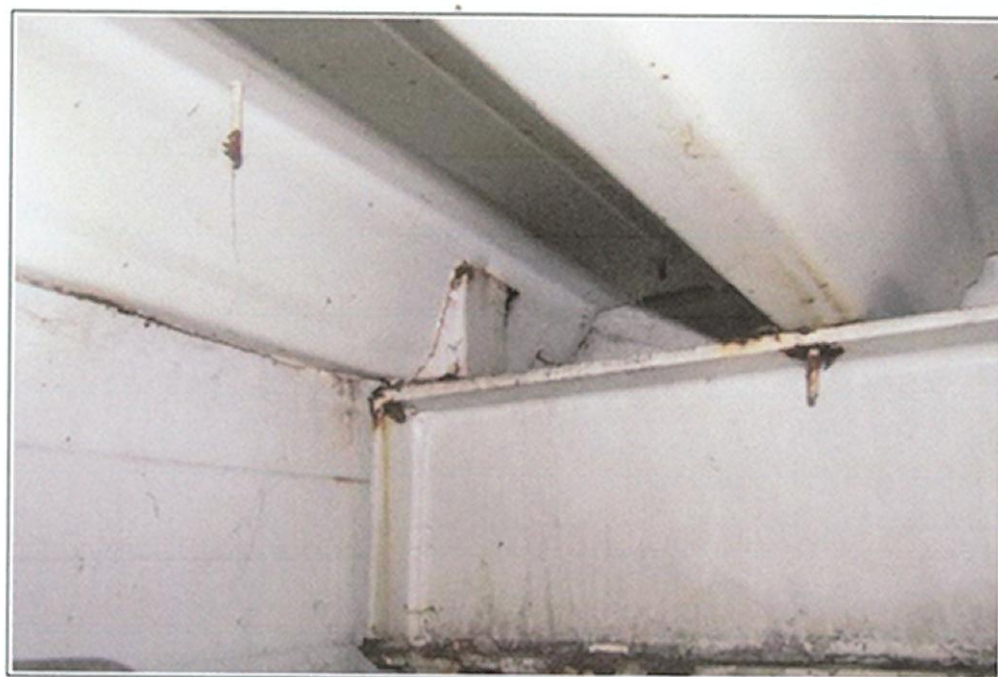
Fot. 30. Hala (od B18) – Korozja (przykłady)
