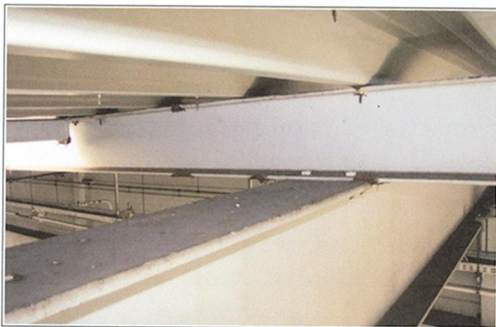
Foto 21. Hala (od B18) – Widok na belki wsporcze dachu - widoczne zanieczyszczenia stałe na powierzchniach poziomych konstrukcji dachu, występujące praktycznie na całej jego powierzchni.
