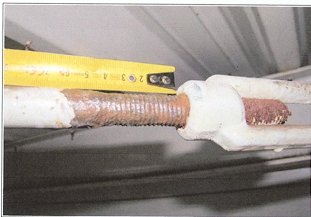
Foto 25. Hala (od B18) – Korozja gwintu ściągu prętowego – cd.
