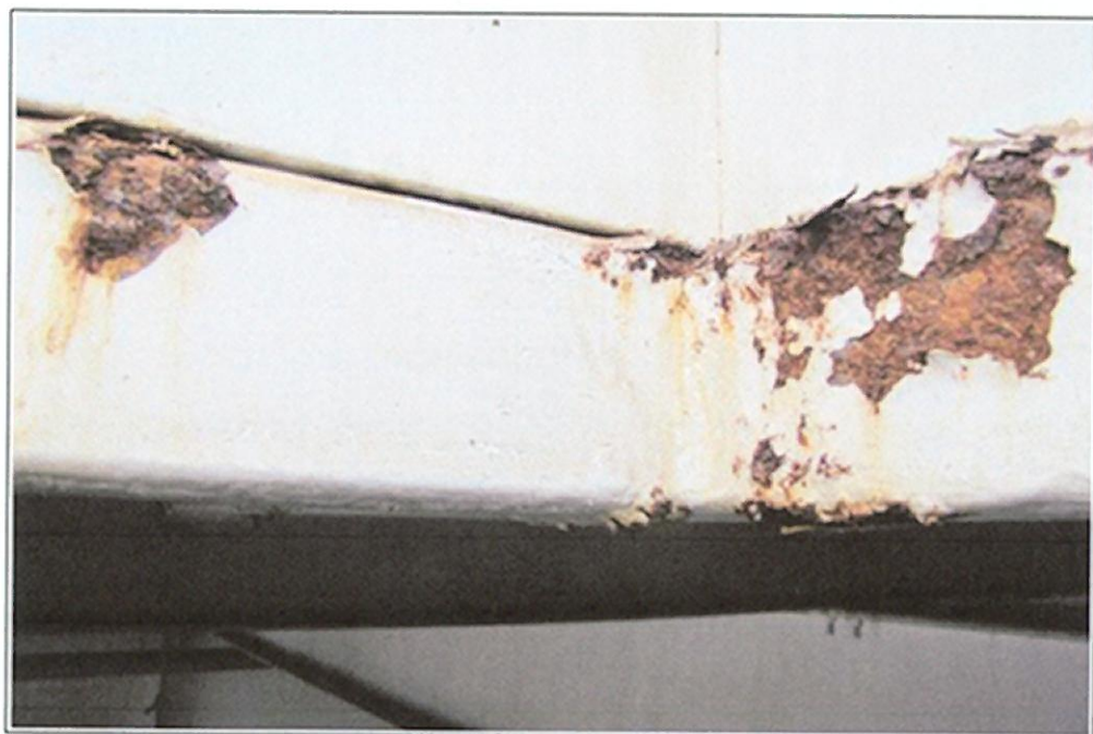
Fot. 46. Hala (od B18) – Kłapa dymowa/światlik 4 – korozja (bez perforacji)
