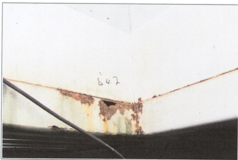
Fot. 4. Hala (od B18) – Kłapa oddymiania/światlik 7 –korozja perforacyjna
